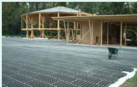
Bodenbefestigung einer Offenstallung auf Wiesenboden (vor Verfüllung)
