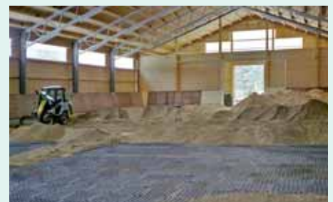
TTE®-Gitterblock speziell für Reithallen mit integrierten Wasserspeichern (effektiv 8 l/m 2 ).
