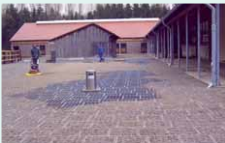
TTE®-Auslauf, befüllt mit Rundkiesel, vor dem Aufbringen der Tretschicht.
