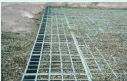
Das TTE®-System lässt sich auch im Winter auf gefrorenem Boden verlegen.
