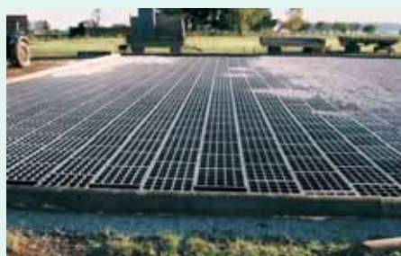
Natürlich ohne herkömmliche Tragschicht: Flacher Oben-Aufbau direkt auf die Wiese mit nur 5 cm Rundkiesel-Horizontal- drainage und TTE®-Gitterplatten .
