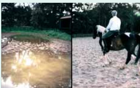
Sanierung einfach und enorm günstig: Mittels Oben-Aufbau der 10 cm TTE®- Drainagen-Tragschicht auf dem verdichteten Reitplatz.
