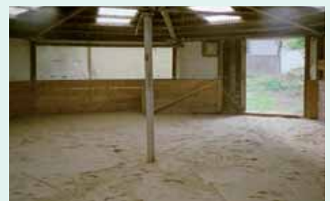
Sanierung einfach und enorm günstig: Mit- tels Oben-Aufbau der 10 cm TTE®-Drai- nagen-Tragschicht auf dem verdichteten Reitplatz.
