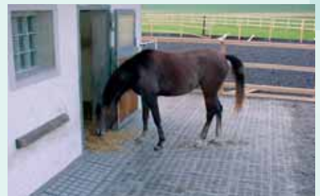
TTE®-Pflasterflächen sind wasserdurchlässig und leicht zu reinigen.
